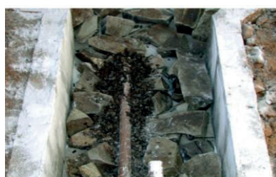
Figura 25 - Filtro de captação instalado na nascente
