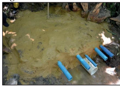
Figura 14 - Depósito de água coberto com argamassa de solo cimento
