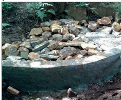
Figura 21 - Pedras colocadas em uma nascente com proteção do tipo trincheira
