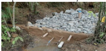
Figura 15 - Detalhes da proteção de uma nascente na etapa final de construção
