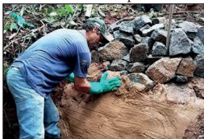
Figura 13 - Proteção de nascente com argamassa de solo cimento sobre pedras
