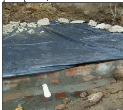
Figura 29 - Colocação da lona para proteção da nascente
