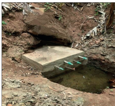
Nascente protegida com depósito de água em sua base
