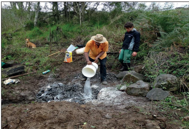
Figura 23 - Detalhe da desinfecção das pedras antes do lacramento da nascente
