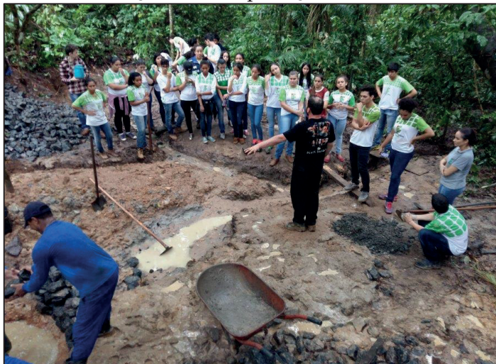
Figura 19 - Mobilização e capacitação, em serviço, durante a construção de uma proteção de nascente
