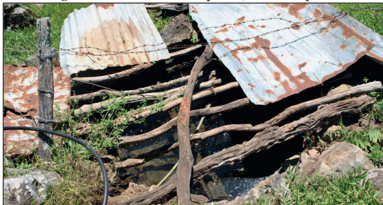
Figura 1 - Nascente com proteção inadequada
