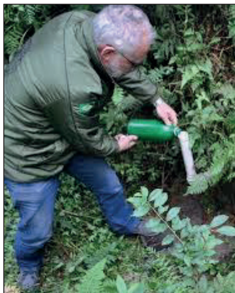
Figura 33 - Realização da desinfecção da água do depósito da nascente
