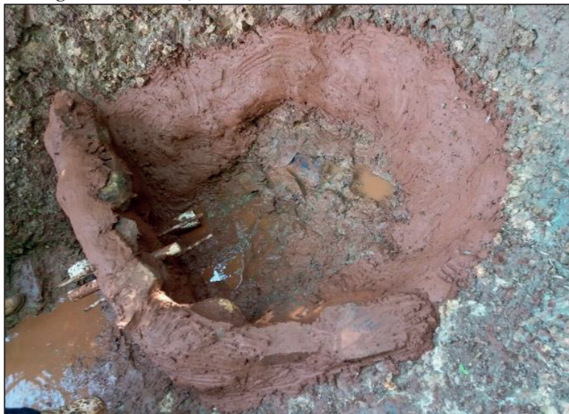
Figura 27 -Proteção de nascente feita com solo cimento
