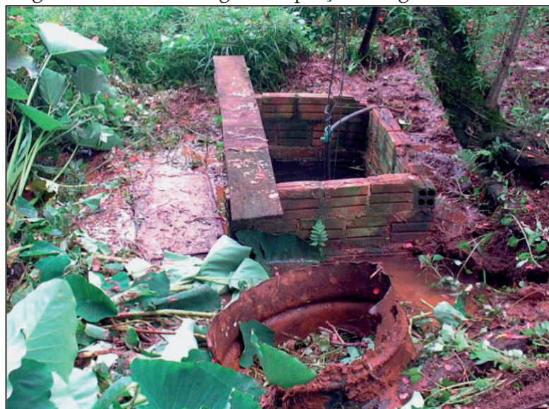
Figura 2 - Sistema antigo de captação de água em nascente.
