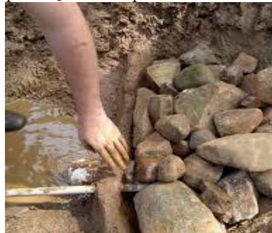
Figura 22 - Canos colocadas em uma nascente com proteção do tipo solo cimento
