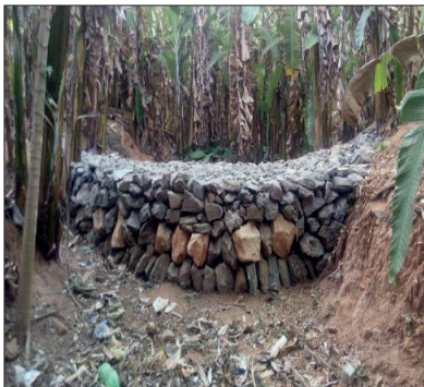
Aspecto de uma barragem de pedra recém construída
