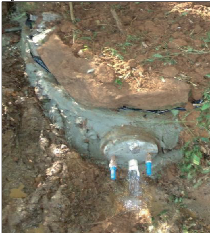
Figura 26 - Proteção de uma nascente modelo Caxambu
