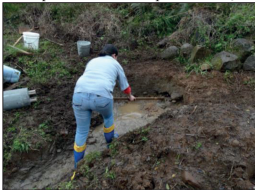
Figura 20 - Limpeza da nascente para colocação de pedras
