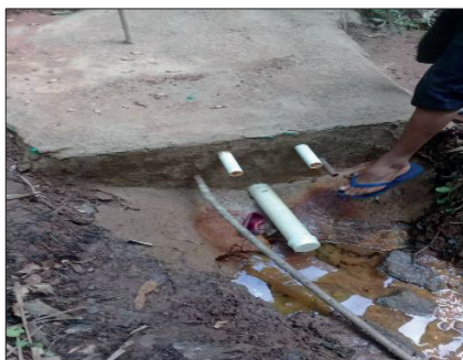
Nascente protegida com encanamento de água para a casa do agricultor
