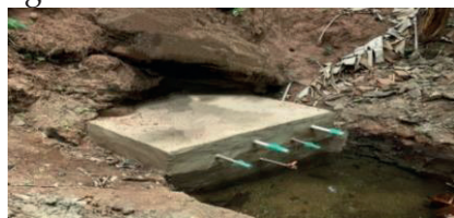
Figura 16 - Nascente com estrutura de fornecimento de água instalada
