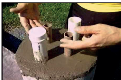
Figura 10 - Preparação do tubo do modelo Caxambu de proteção de nascente
