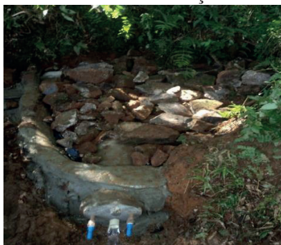
Figura 11 - Proteção Caxambu em construção
