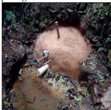
Figura 28 - Nascente protegida com solo cimento
